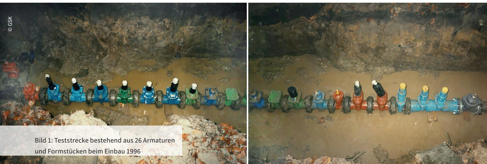
Bild 1: Teststrecke bestehend aus 26 Armaturen und Formstücken beim Einbau 1996
